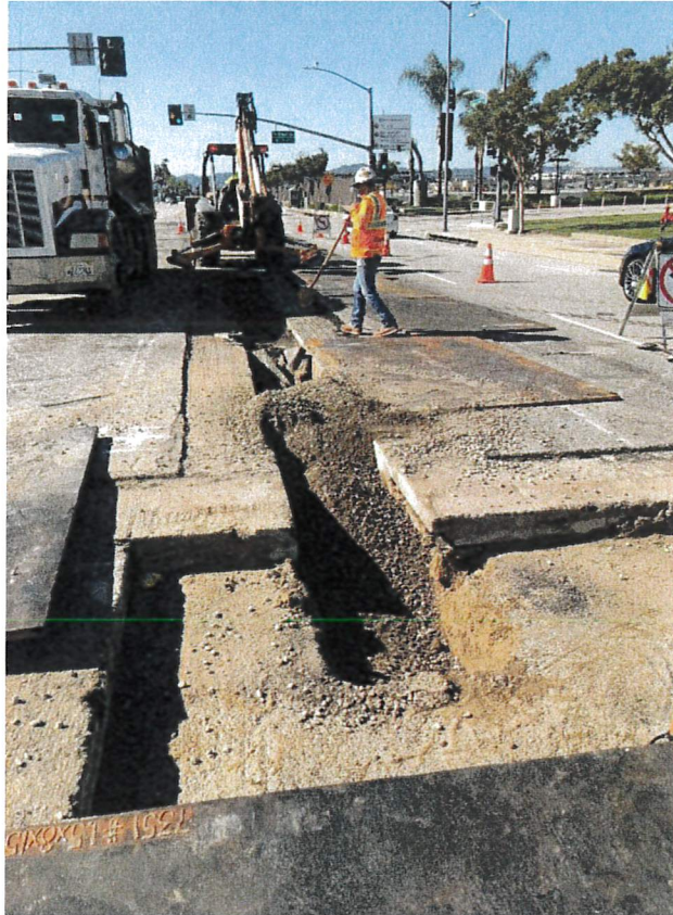
Conduit Installation: Trenching
